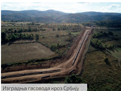
Изградња гасовода кроз Србију
