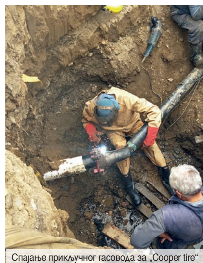
Спајање прикључног гасовода за „Cooper tire“
