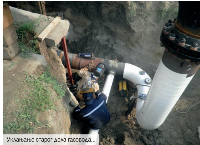
...и заваривање новог излазног дела
